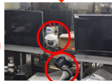
パソコンの電源を入れ、作業する手元のモニタリングカメラとバーコードリーダーの動作確認
